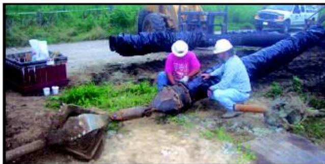
Рисунок 38 Прокладка трубопровода методом горизонтально направленного бурения.
