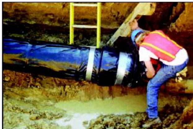
Рисунок 43 Покрытие труб полиэтиленовым рукавом.
