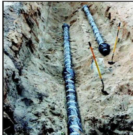
Рисунок 45 Картриджный метод укладки труб.
