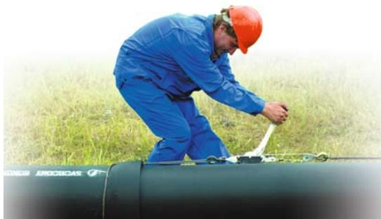
Перед началом монтажных работ внутренняя поверхность трубы и ФЧ (особенно кольцевой паз для манжеты) и наружная поверхность гладкого конца трубы и ФЧ до опускания их в траншею должны быть очищены от посторонних предметов и загрязнений.
